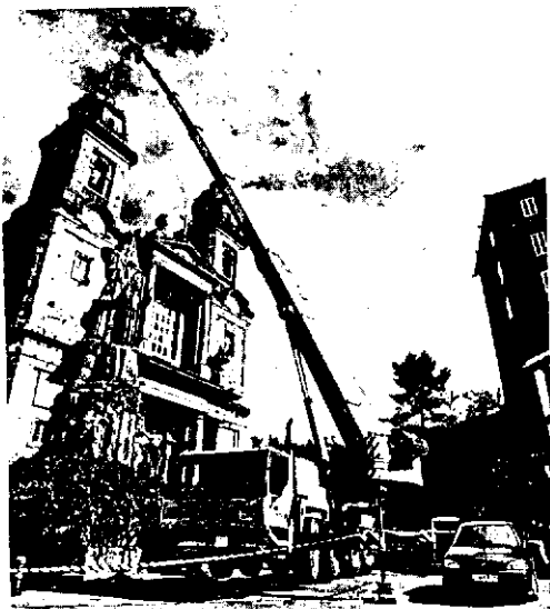
La instalación requiriu una grúa de grandes dimensiones | XOANA SOKER
