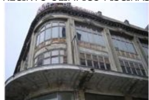
EDIFICIO PLAZA SANTA ANA
