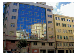
BT118 - EDIFÍCIO DE VIVENDAS
