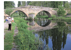
BT362 - PONTE DE PEDRA
