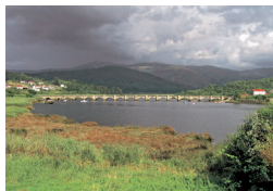
BT365 - PONTE DE PEDRA
