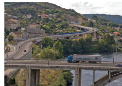
BT361 - PONTE E AUTOVÍA
