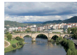
BT329 - PONTE NUNHA CIDADE
