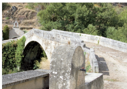
BT364 - PONTE DE PEDRA
