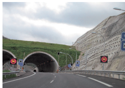
BT359 - TUNEL NUNHA AUTOVÍA
