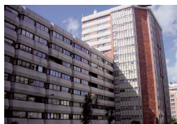
BT115 - EDIFÍCIO DE VIVENDAS
