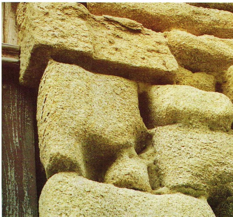
Foto n.º 1. A desagregación areosa intensa provoca un redondeamento dos sillares.
