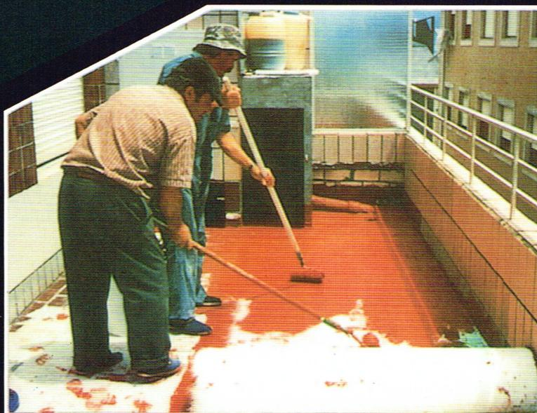
ELASTINOR-Q. Revestimiento elástico impermeabilizante.
