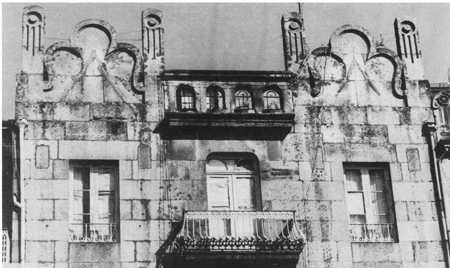
85.-Detalle da fachada.
