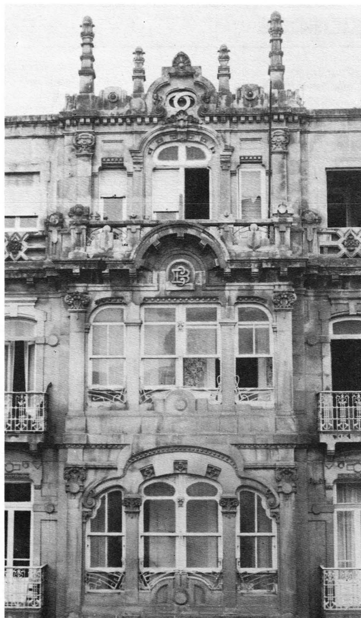
70.-Detalles de fachada.
