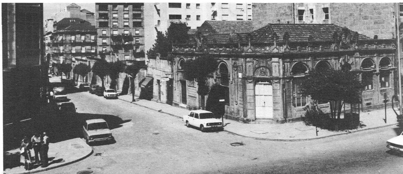
44.-Plano da fachada. 45.- Vista xeral.
