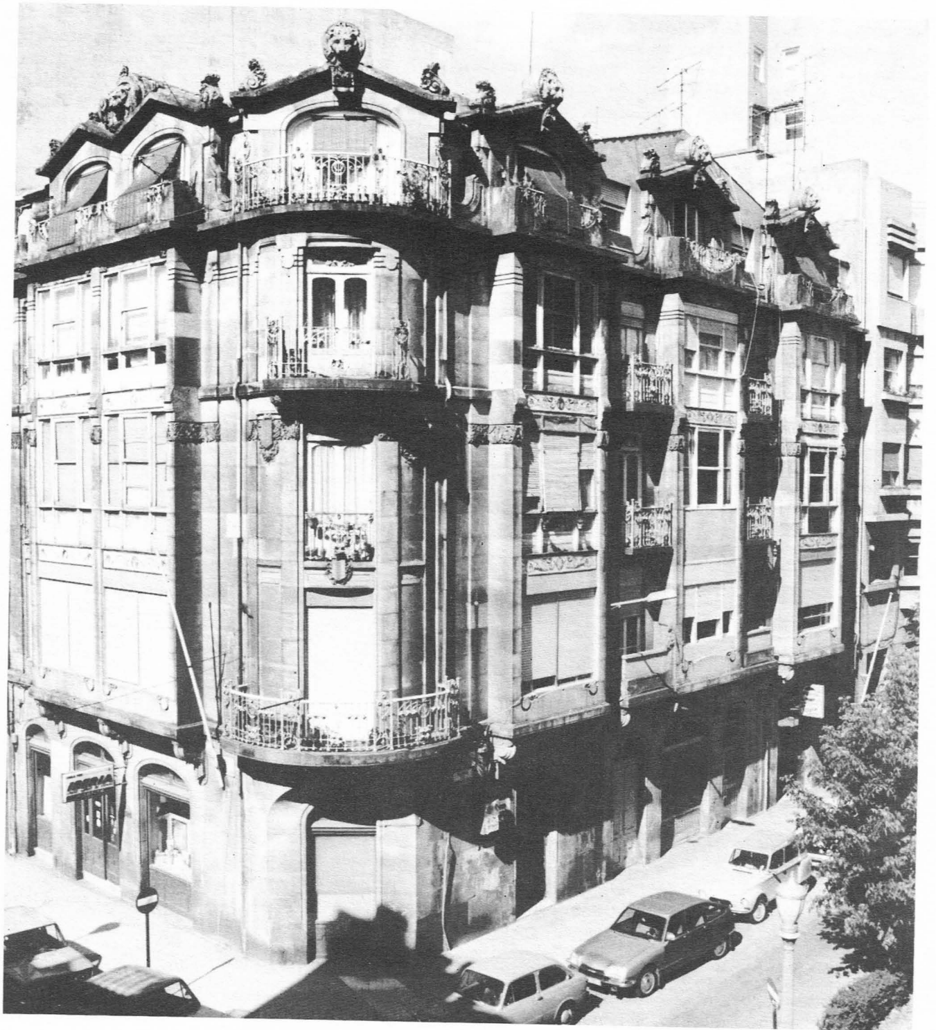
21.-Casa de viviendas na Praza de Compostela, esquina a García Olloqui (1912).
