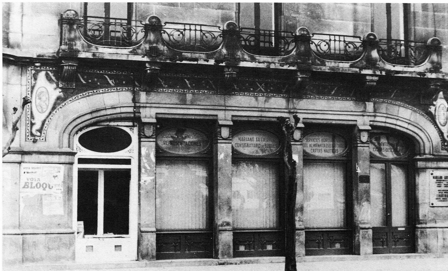
109.-Detalle da fachada.
