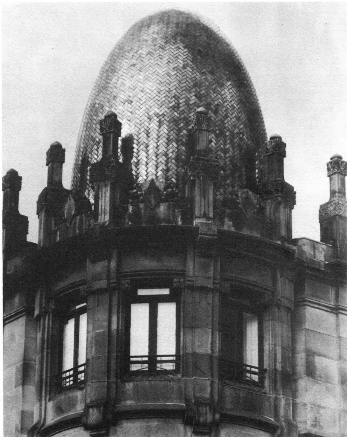
112.-Detalle da parte alta do corpo de esquina.
