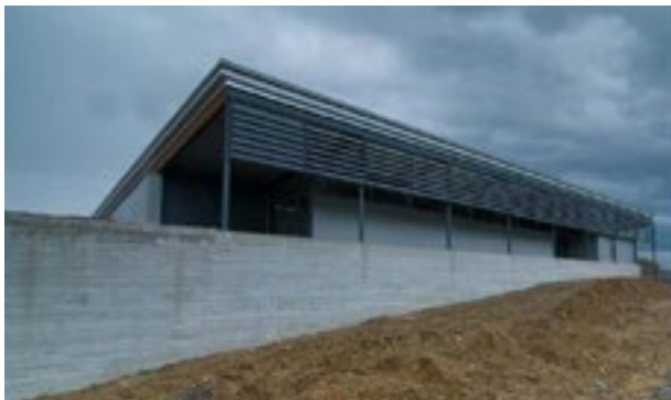
Arrokabe arquitectos Centro de formación da natureza e medioambiente
