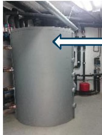
La **Bomba de Calor** aportará su producción a un **acumulador de 2.000 litros** en la parte baja, como energía de apoyo, para que de este modo el calor más barato aporte energía para las pérdidas del acumulador y para el calentamiento inicial del agua más fría.
